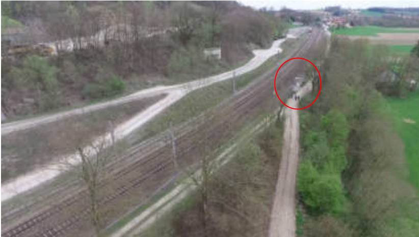
Abbildung 2: ÖBB Strecke Passau – Wels, Höhe Allerding mit Frauscher Testcenter (rot eingerahmt)
