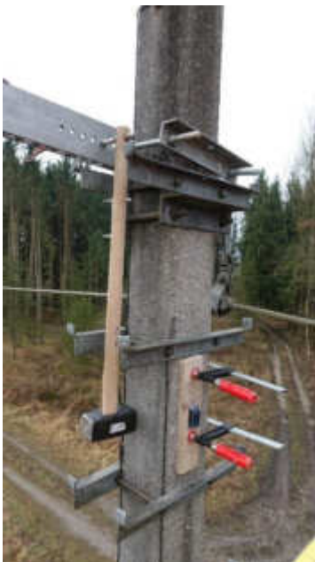
Abbildung 13: Hammermontage am Oberleitungsmast.
